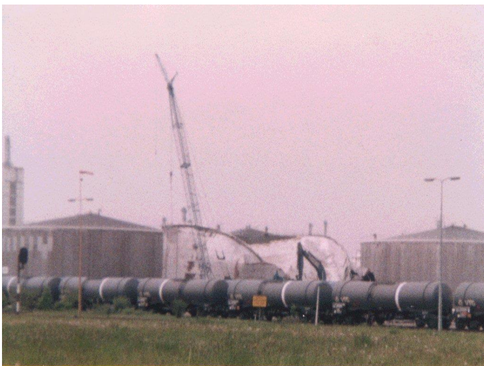
Рис. 1. Схлопывание резервуара из-за образовавшегося вакуума после быстрого истечения продукта через зону коррозионного повреждения в районе уторного уголка.
